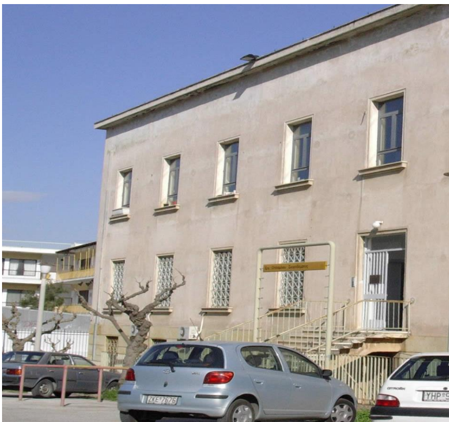
Κτίριο Εργαστηρίου Οπλισμένου Σκυροδέματος
