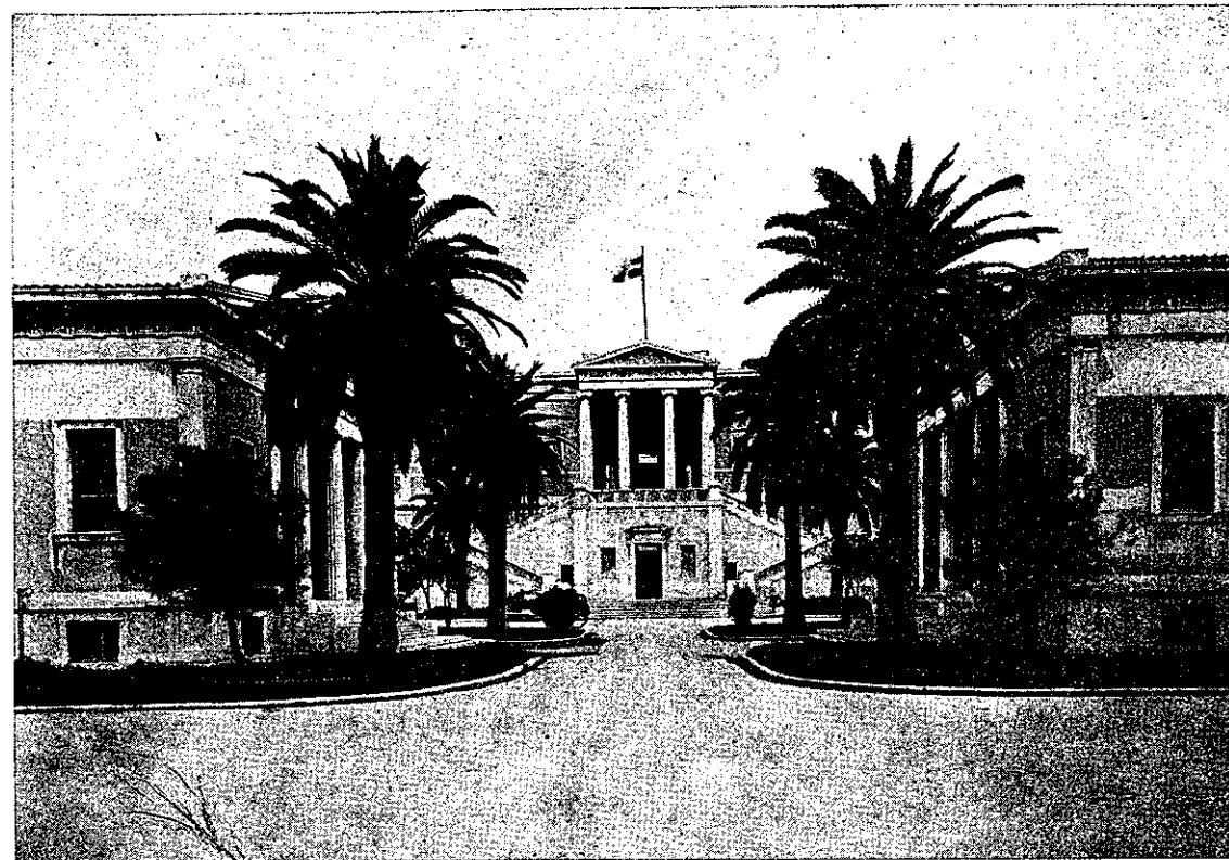
ΩΦΙΣ ΚΤΙΡΙΩΝ ΕΠΙ ΤΗΣ ΟΔΟΥ 28ης ΟΚΤΩΒΡΙΟΥ
