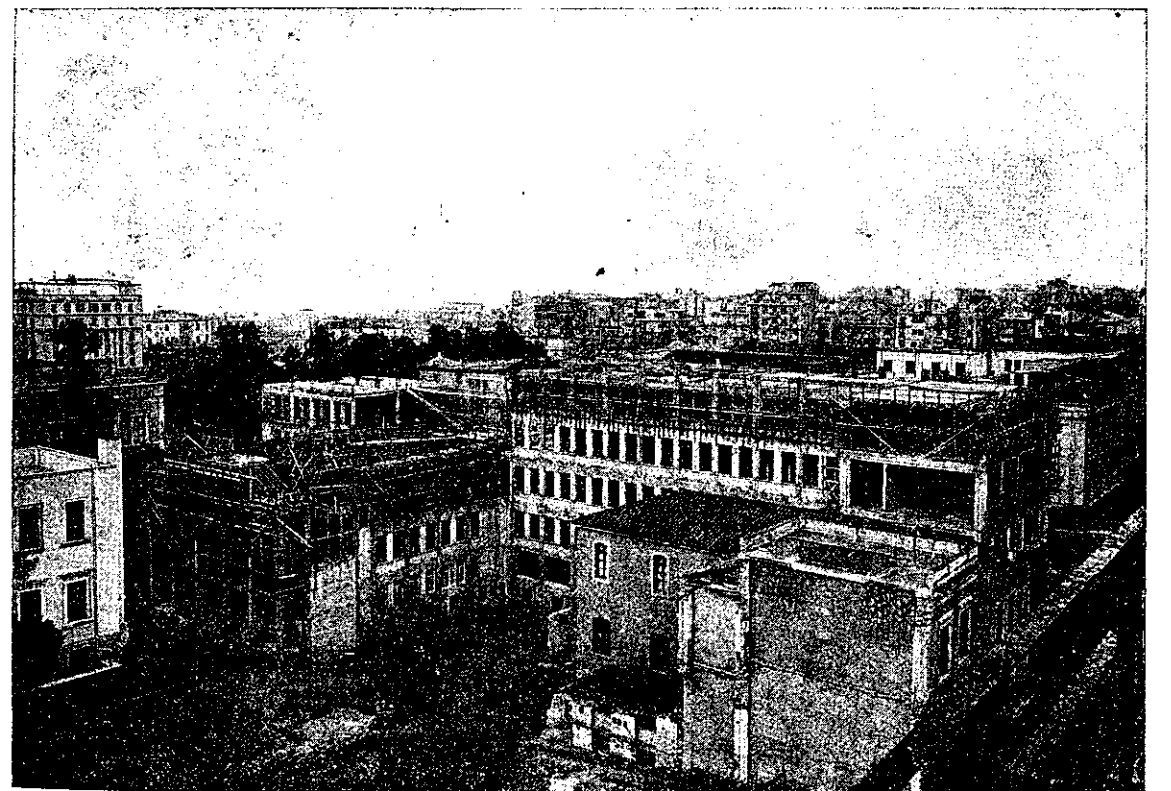
ΟΨΙΣ ΚΤΙΡΙΩΝ ΕΝ ΕΚΤΕΛΕΣΕΙ
