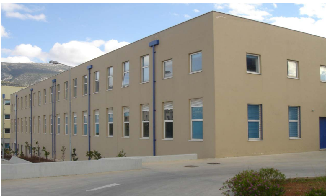
Κτήριο Τομέα Γεωτεχνικής
