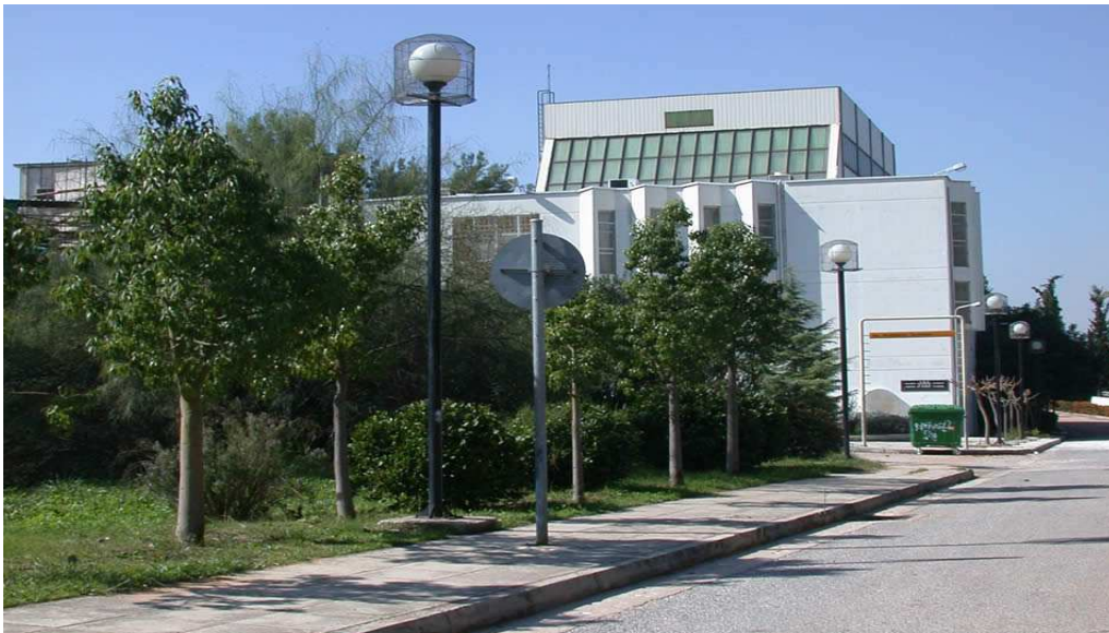
Κτήριο Εργαστηρίου Αντισεισμικής Τεχνολογίας
