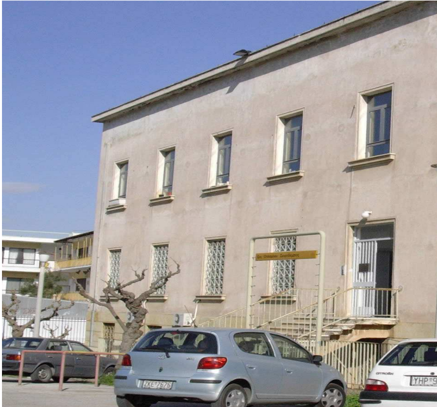
Κτήριο Εργαστηρίου Οπλισμένου Σκυροδέματος
