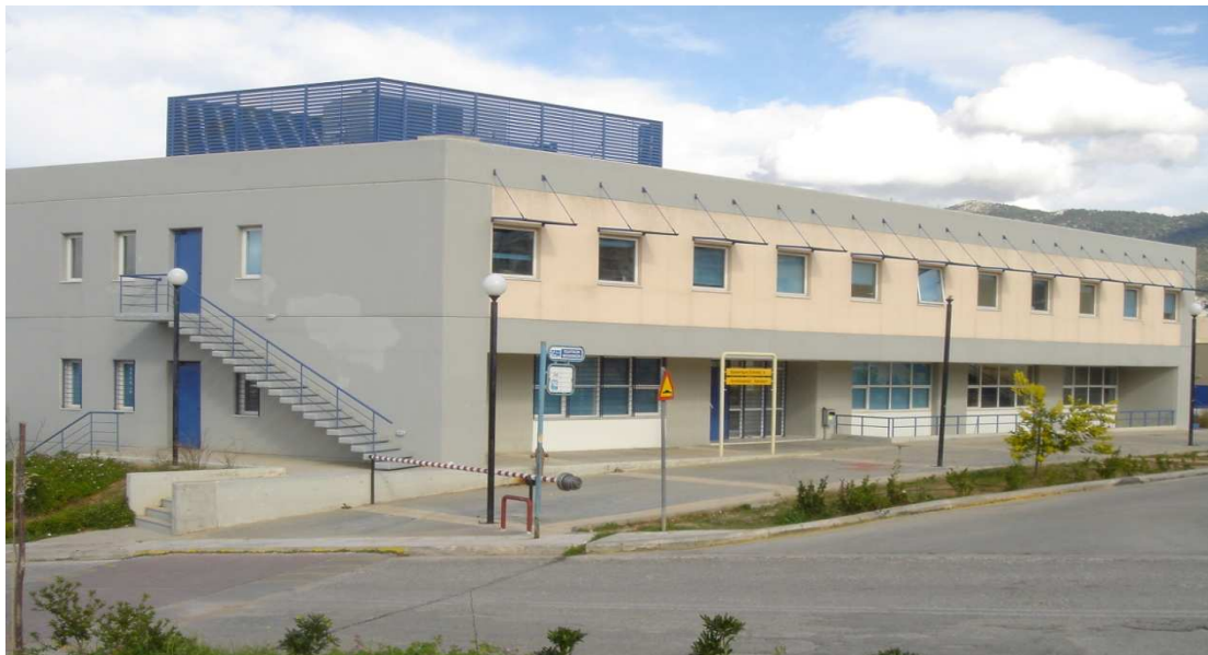
Κτήριο Εργαστηρίου Στατικής και Αντισεισμικών Ερευνών
