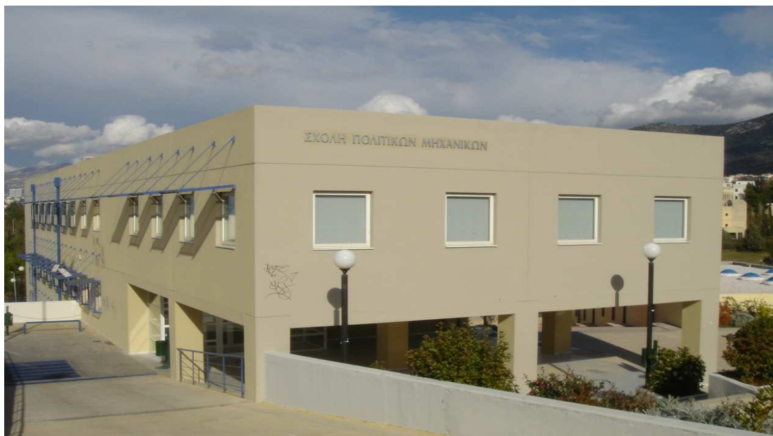
Κτήριο Διοίκησης Σχολής Πολιτικών Μηχανικών.
