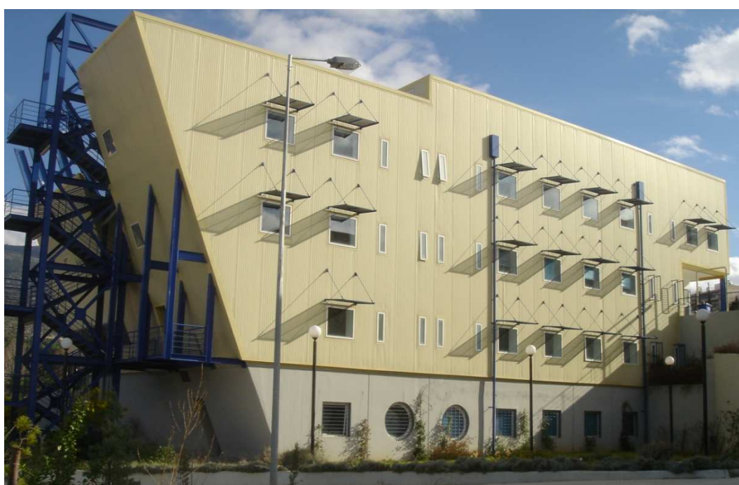
Κτήριο Εργαστηρίου Μεταλλικών Κατασκευών
