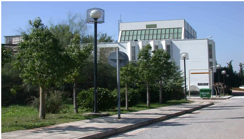
Κτήριο Εργαστηρίου Αντισεισμικής Τεχνολογίας
