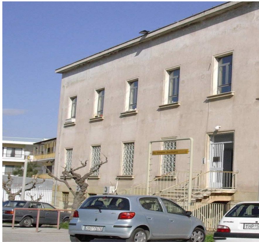
Κτήριο Εργαστηρίου Οπλισμένου Σκυροδέματος
