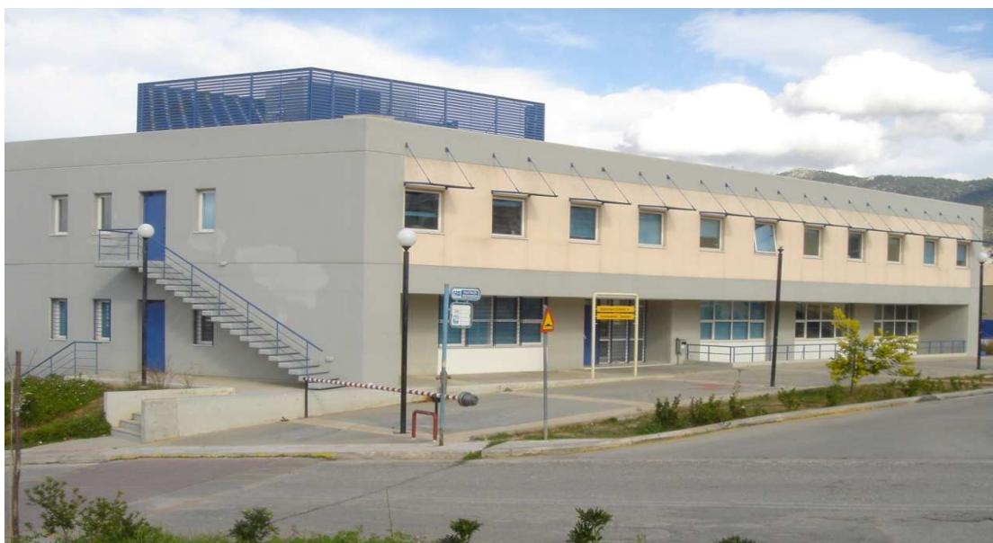
Κτήριο Εργαστηρίου Στατικής και Αντισεισμικών Ερευνών
