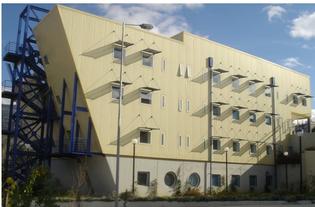
Κτήριο Εργαστηρίου Μεταλλικών Κατασκευών
