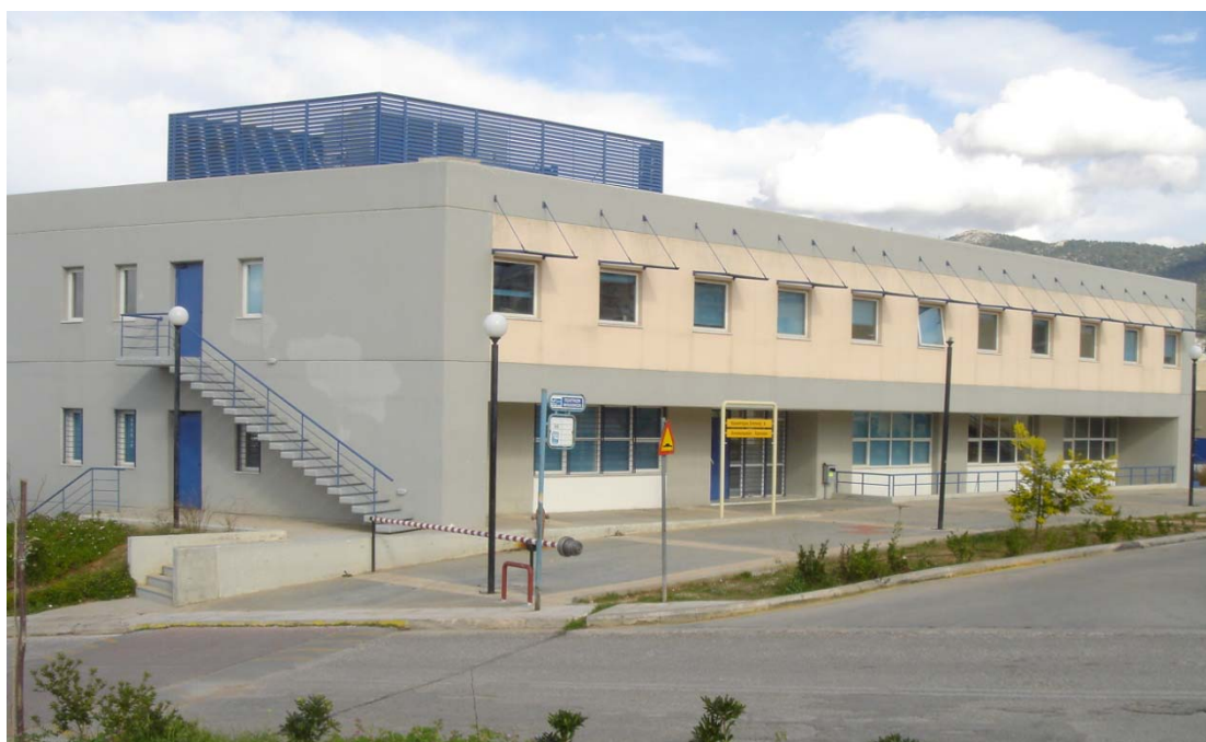
Κτήριο Εργαστηρίου Στατικής και Αντισεισμικών Ερευνών
