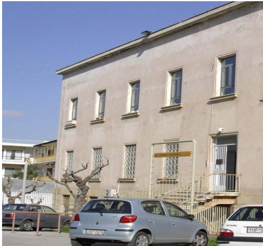
Κτήριο Εργαστηρίου Οπλισμένου Σκυροδέματος
