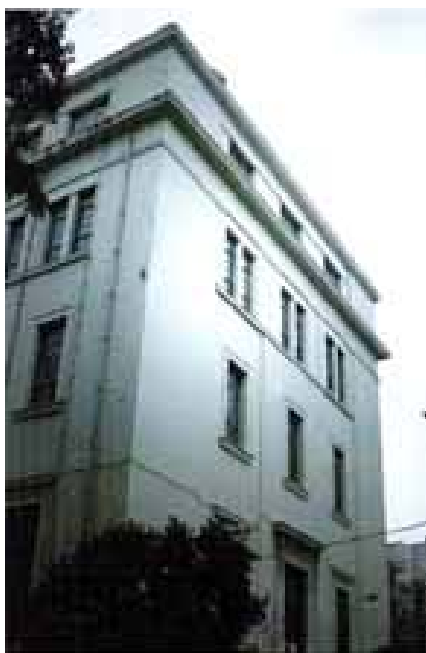
Το κτήριο Γκίνη στο ιστορικό ίδρυμα του Εθνικού Μετσόβιου Πολυτεχνείου επί της οδού Πατησίων.
