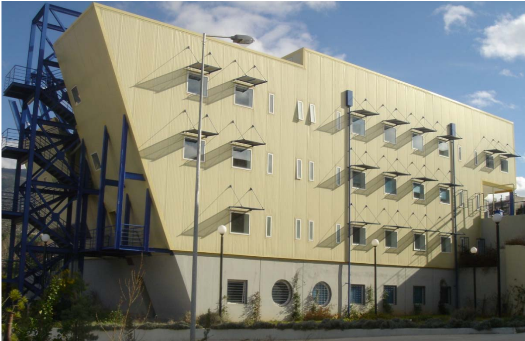
Κτήριο Εργαστηρίου Μεταλλικών Κατασκευών
