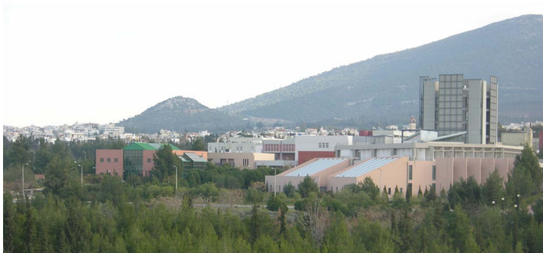
Το κτήριο Διοίκησης, το Θωμαΐδειο Κέντρο Εκδόσεων και η βιβλιοθήκη στην Πολυτεχνειούπολη Ζωγράφου
