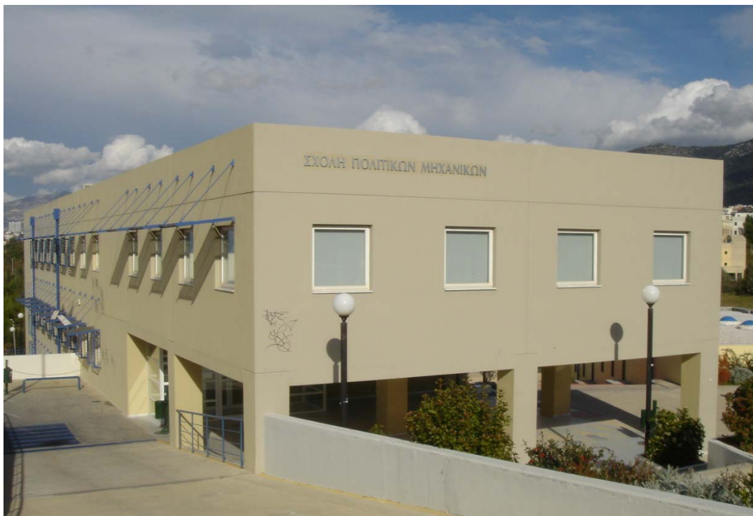
Κτήριο Διοίκησης Σχολής Πολιτικών Μηχανικών.
