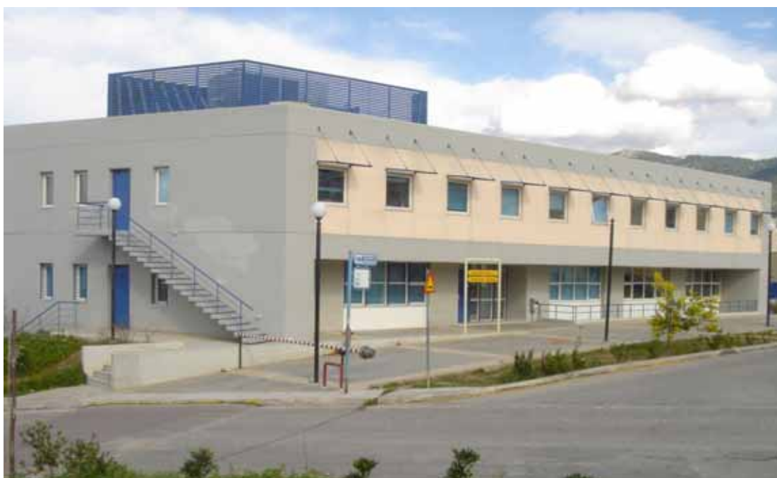
Κτήριο Εργαστηρίου Στατικής και Αντισεισμικών Ερευνών
