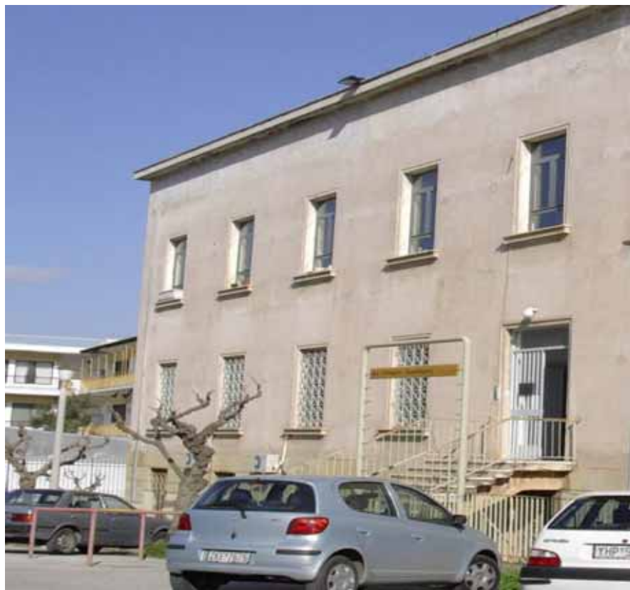
Κτήριο Εργαστηρίου Οπλισμένου Σκυροδέματος
