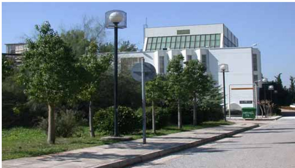
Κτήριο Εργαστηρίου Αντισεισμικής Τεχνολογίας
