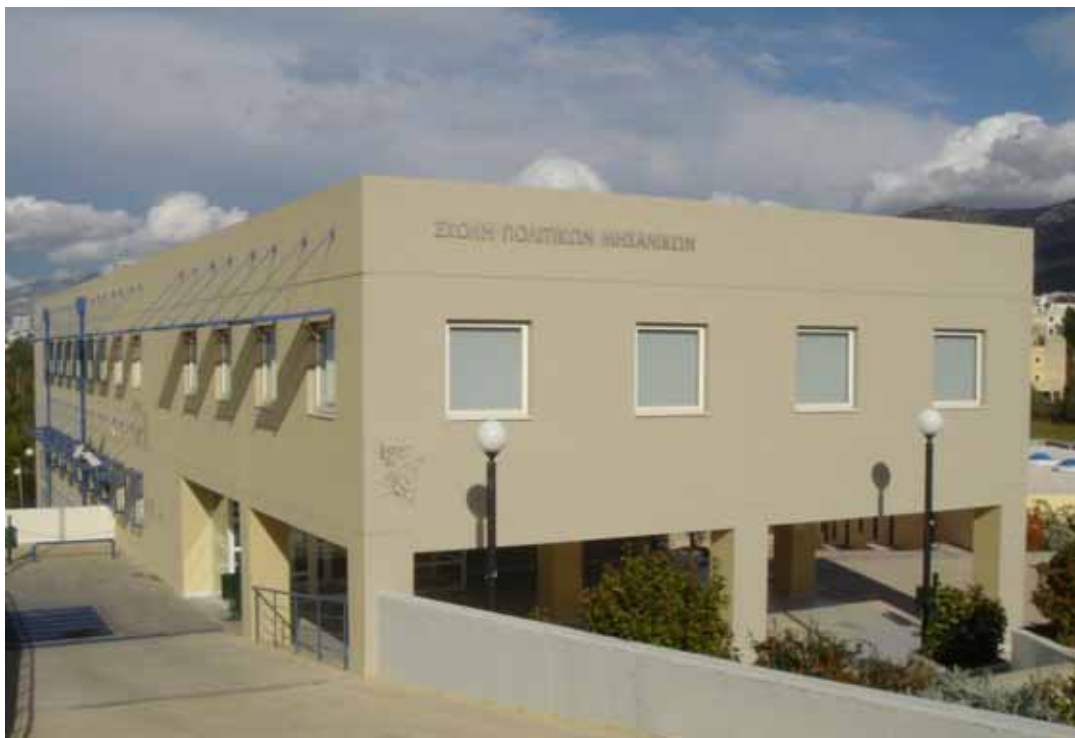
Κτήριο Διοίκησης Σχολής Πολιτικών Μηχανικών.
