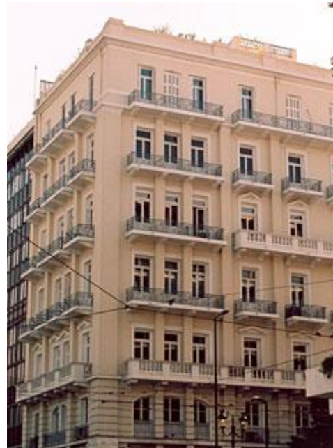
Φιλελλήνων 1 & Όθωνος, Έτος: 1917 , από οπλισμένο σκυρόδεμα
