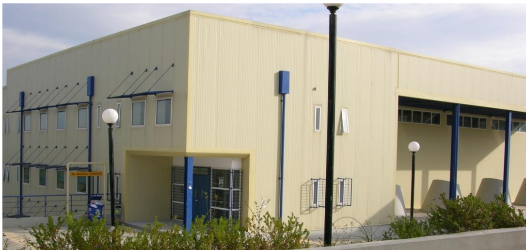
Κτήριο Εργαστηρίου Μεταλλικών Κατασκευών
