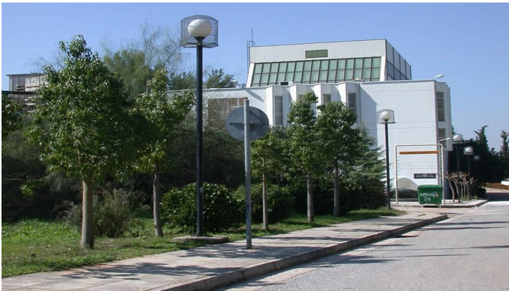
Κτήριο Εργαστηρίου Αντισεισμικής Τεχνολογίας
