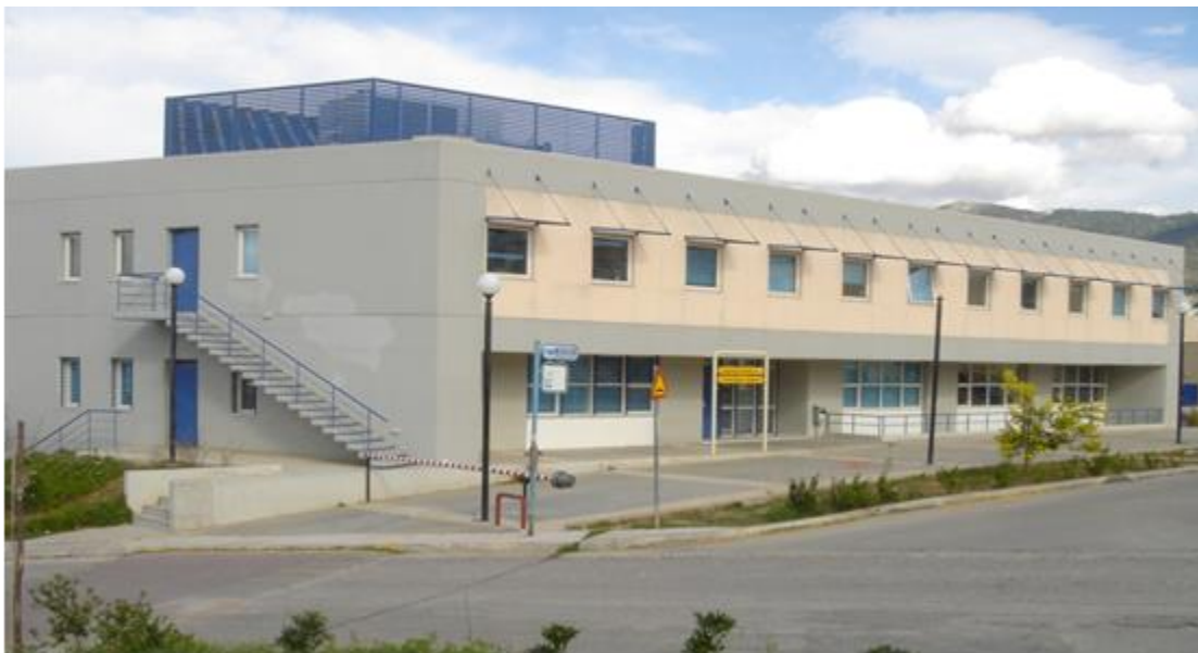
Κτήριο Εργαστηρίου Στατικής και Αντισεισμικών Ερευνών
