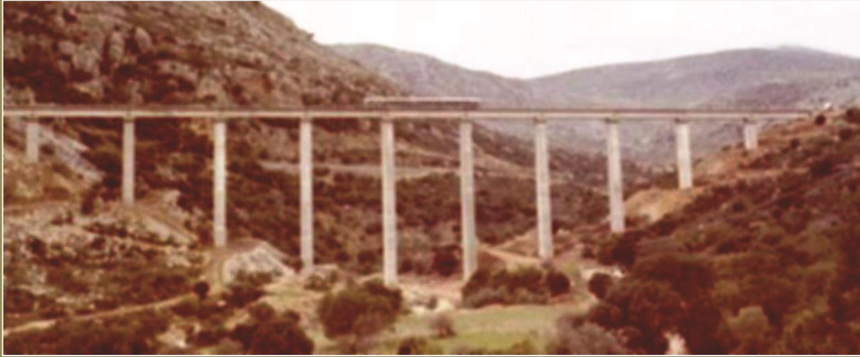
Σιδηροδρομική γέφυρα Αχλαδόκαμπου (1970) (Παγώνης-Χρονέας-Κινάτος ΠΑΝΤΕΧΝΙΚΗ ΑΕ)
