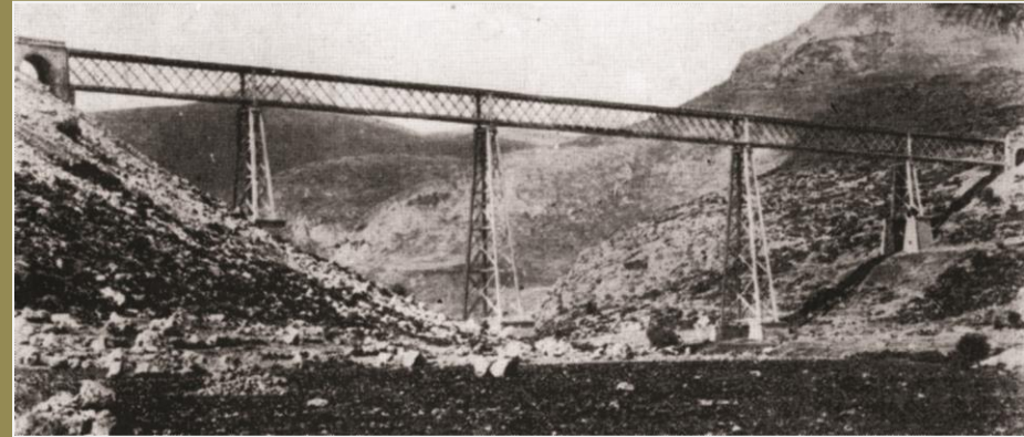
Γέφυρα Αχλαδόκαμπου (συνεχής) L = 253.0\text{ m} , \text{max}l = 72.20\text{m} , ύψος βάθρων > 40.0\text{m}
