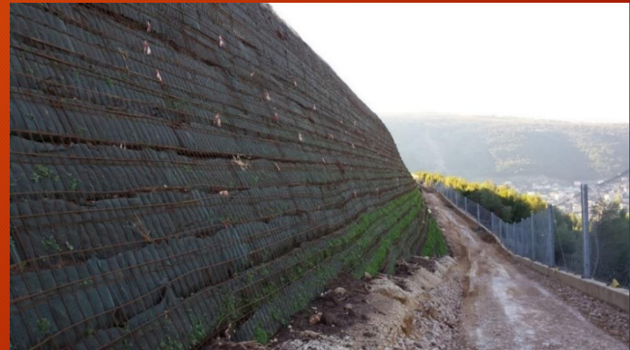
Όψη - Χρήση τεχνικής περιτύλιξης οπλισμών
