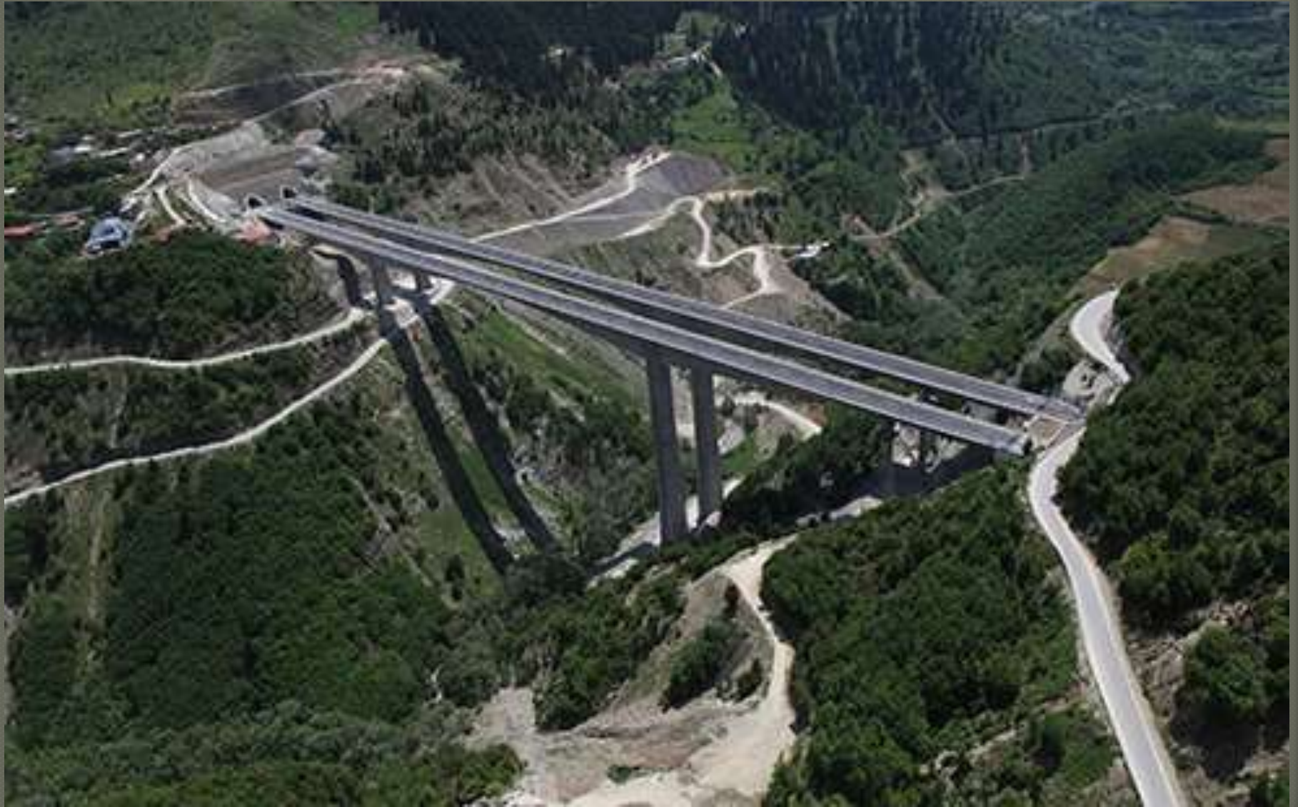
Εγνατία Οδός – Γέφυρα Βοτονοσίου (κεντρικό άνοιγμα 230μ)
