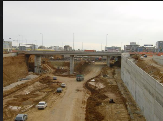
Έργα στον κόμβο Κηφισίας (προσωπικό αρχείο)
