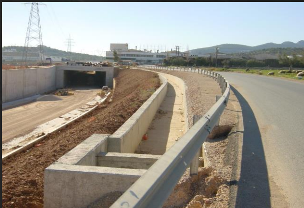
Κατασκευή έργων Αττικής οδού στην Ελευσίνα (προσωπικό αρχείο)
