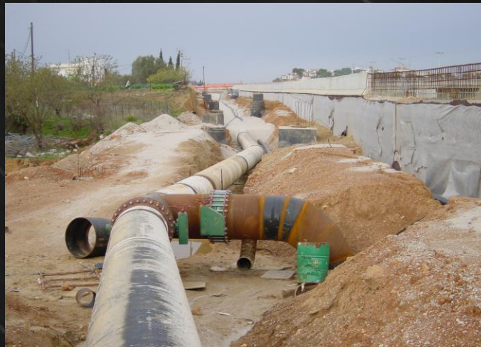
Έργα ύδρευσης στον παράδρομο της Αττικής Οδού στο Μαρούσι (προσωπικό αρχείο)
