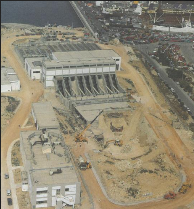
Κατασκευή έργων ανάντη Ψυτάλλειας στον Ακροκέραμο
