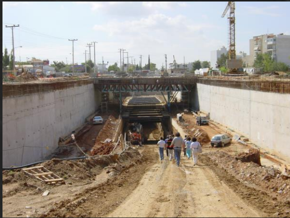
Είσοδος σήραγγας εκτροπής Ποδονίφτη (προσωπικό αρχείο)
