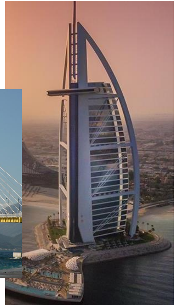
Burj Al Arab Hotel, Dubai Θεμελιωμένο σε τεχνητό νησί
