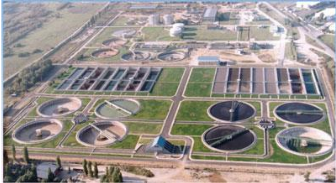
Εγκαταστάσεις διυλιστηρίου νερού-Θεσσαλονίκη
