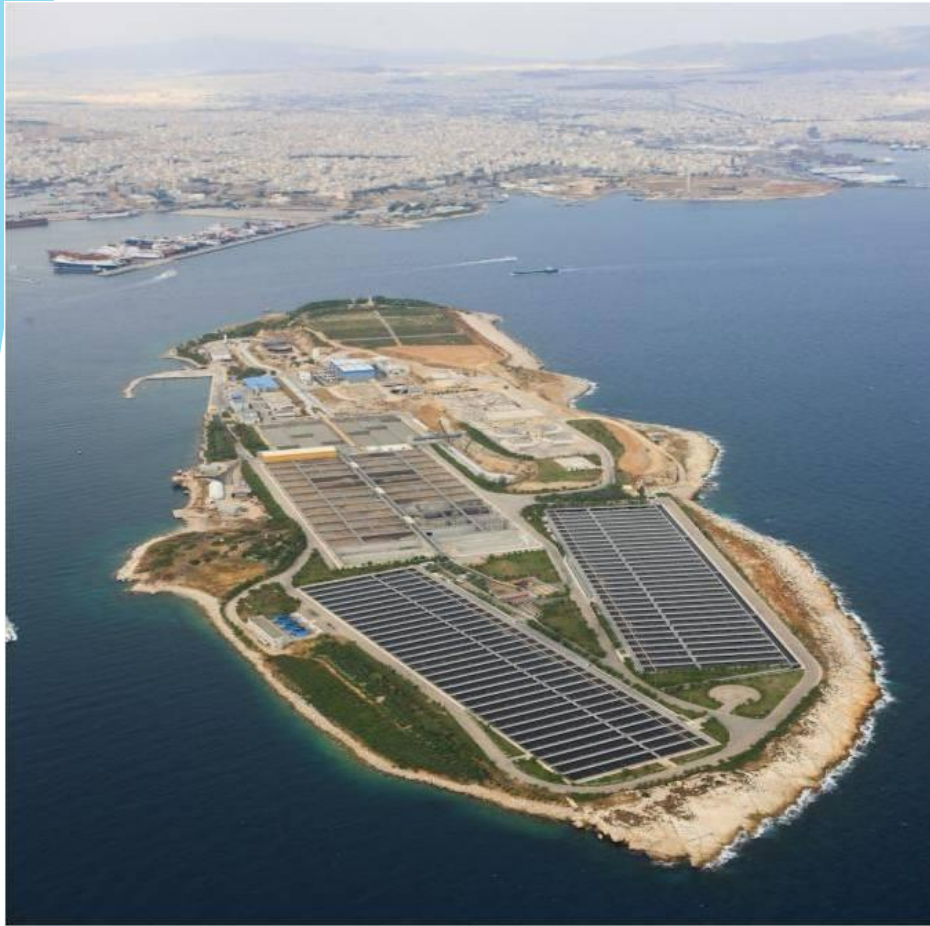
Επεξεργασία Λυμάτων -Ψυττάλεια
