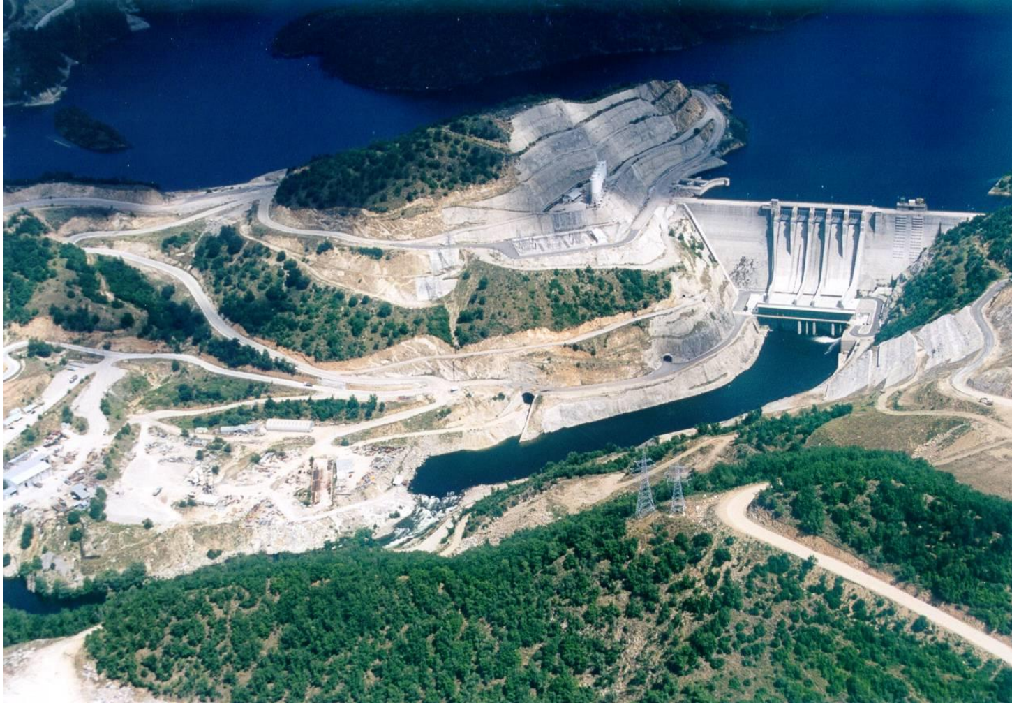
Φράγμα Πλατανόβρυσης-Τύπος RCC
