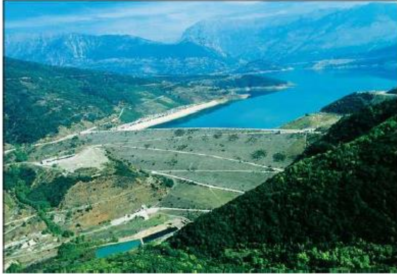
Ταμιευτήρας και υδραγωγείο Μόρνου
